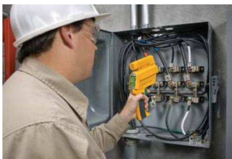
Obr. č. 1 Měření oteplení kontaktů bez vypnutí zdroje
